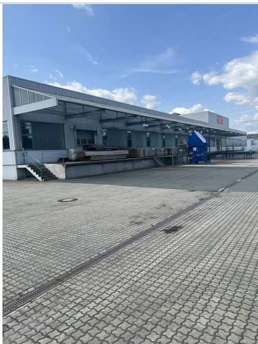
22 Bild 6 Ansicht Rampe
