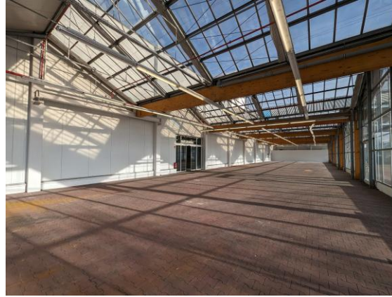
Kalthalle: Blick nach Norden
