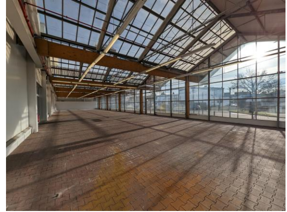
Kalthalle: Blick nach Norden
