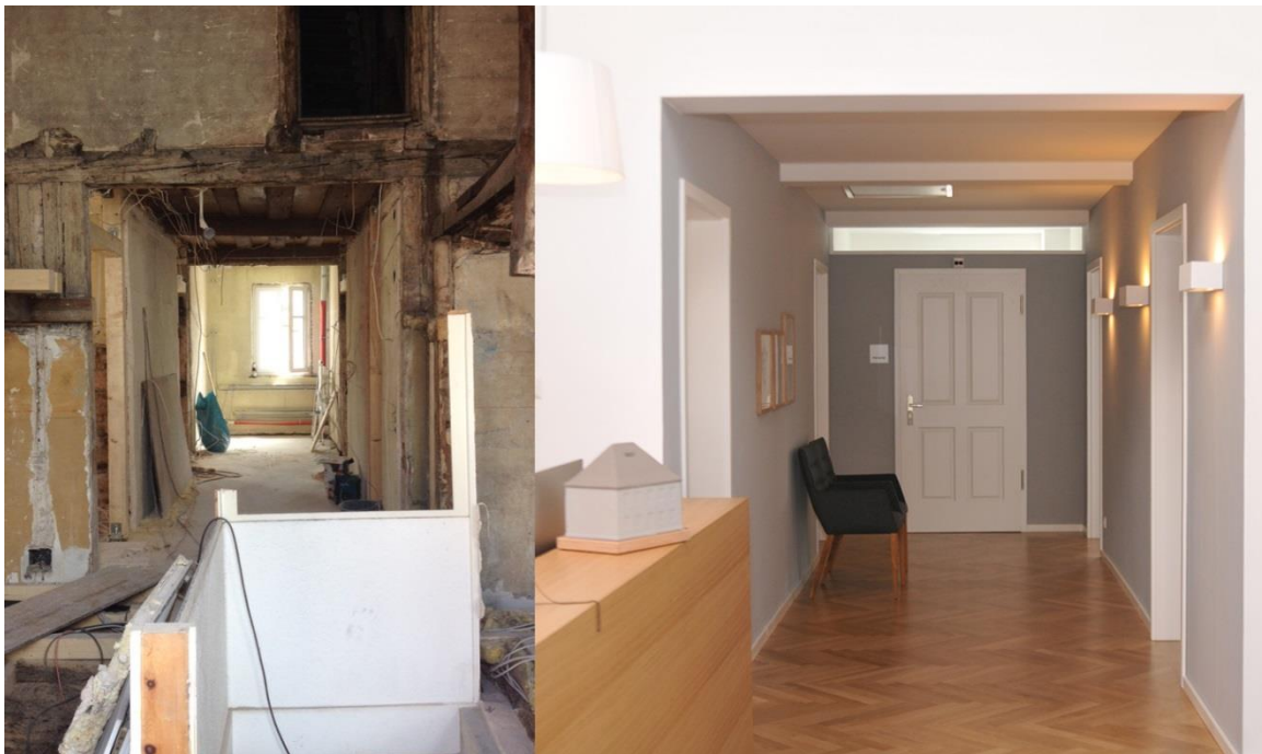
Beispiel einer gelungenen Sanierung / Vorher-Nachher-Beispiel Innenräume (Quelle: www.Zoike.com )
